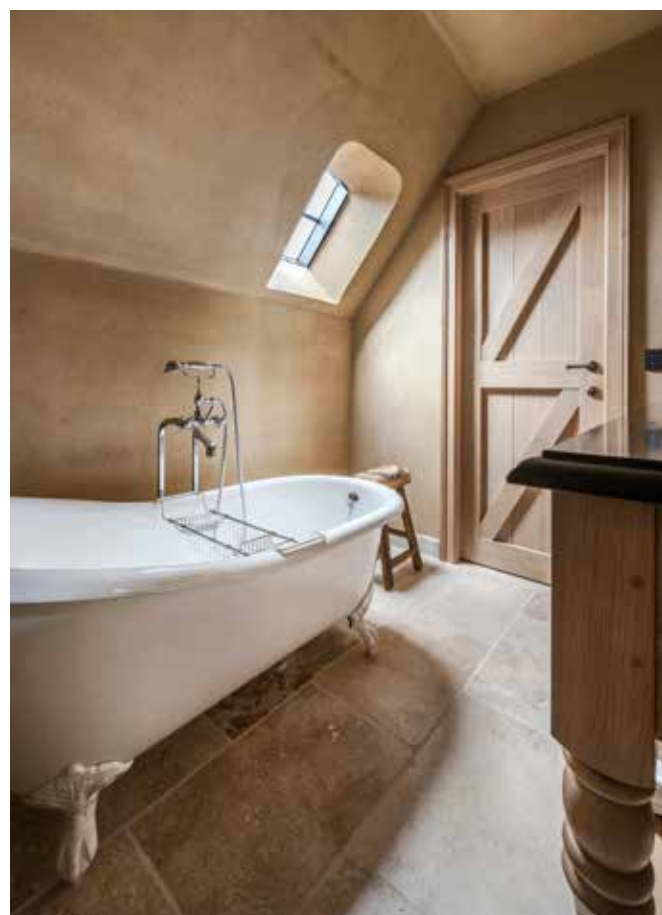
De vensteropeningen zijn uitgeschuind om zoveel mogelijk daglicht naar binnen te halen. De gietijzeren ligbaden zijn verschillend in elke kamer.
